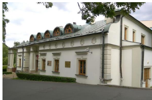
Fotografia 23. Widok na Dwór przy ul. Ćwiklińskiej 1 [4].
